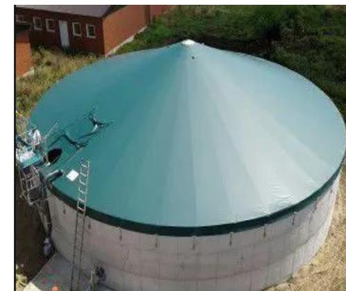
**Cubierta abovedada:** cubierta con una estructura curvada instalada sobre depósitos redondos utilizando piezas de acero y juntas atornilladas.
